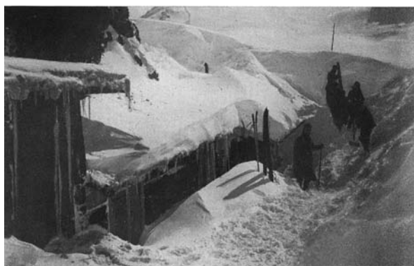
Baraccamenti sulla Forcella
